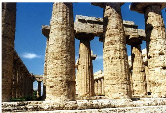
Rys. 1 Entasis – charakterystyczna wypukłość trzonu kolumny w porządku doryckim.)
